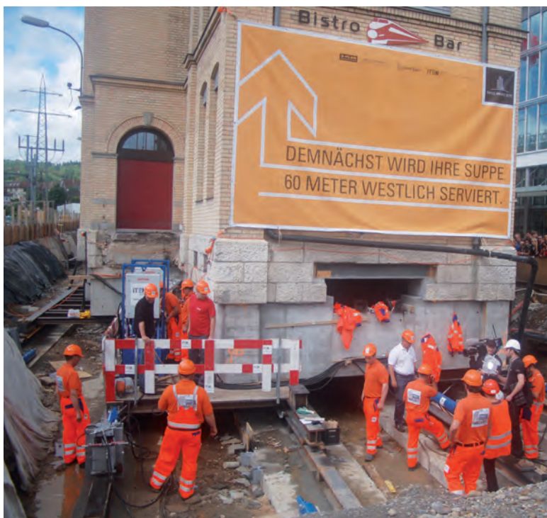
Baukader verschieben historisches ABB-Gebäude beim Bahnhof Oerlikon
