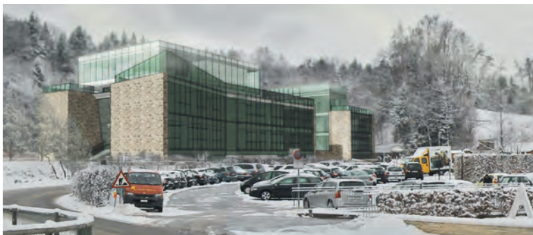
Unser zweites Firmengebäude: Baubeginn Frühjahr 2015
